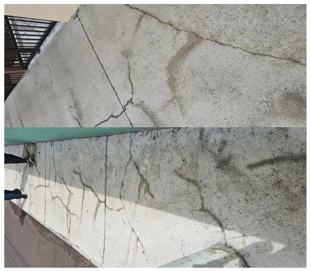
Parte do trecho foi atingida por uma chuva torrencial após a concretagem, por isso o acabamento está rugoso com o agregado bem aparente e precisará ser solucionado essa situação.
