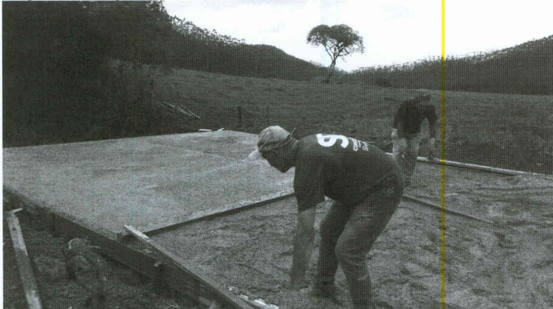
Imagem 2: Execução de Fundação Radier
