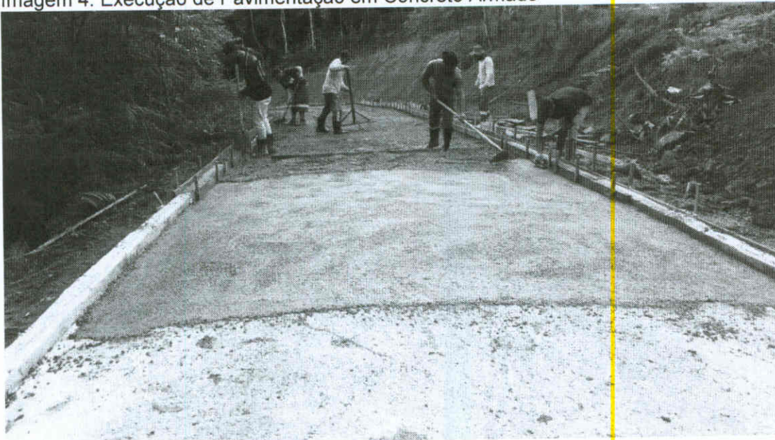
Imagem 4: Execução de Pavimentação em Concreto Armado
