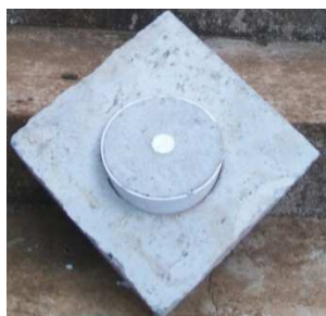
Tampa para Til acoplada no concreto.
