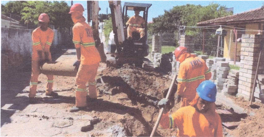
Fotos de Obras de Saneamento da Casan - SC
