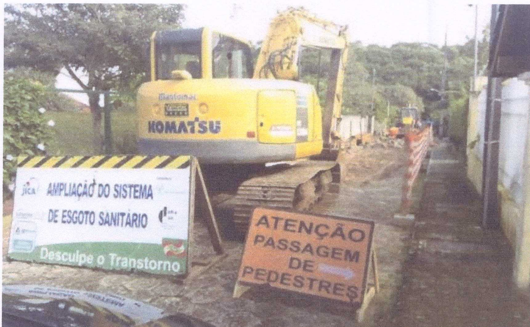
Fotos de Obras de Saneamento da Casan - SC
