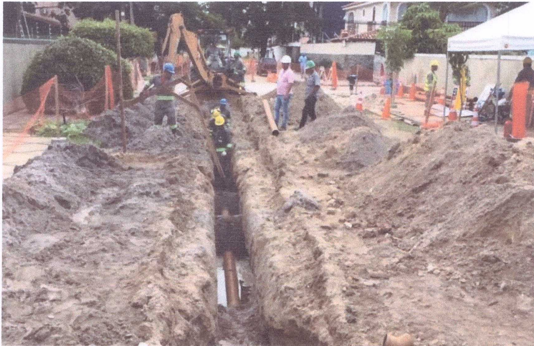
Fotos de Obras de Saneamento da Casan - SC
